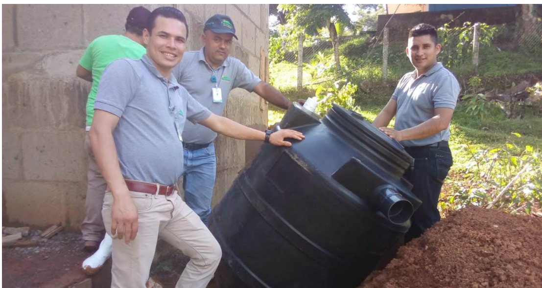
Instalación de un biodigestor. Waslala, RACN.
