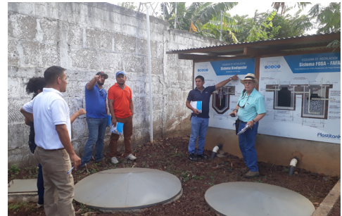
Sistema demostrativo de saneamiento con biodigestor autolimpiable instalado en el Centro SMART, Tipitapa.
