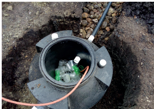
Llenando con agua biodigestor recién instalado.
