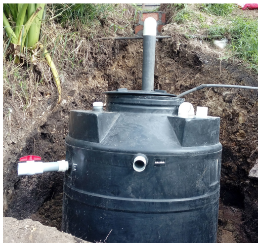
Biodigestor en proceso de instalación.
