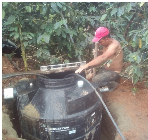
Instalacion de un biodigestor. San Rafael del Norte, Depto. Jinotega.
