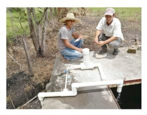
Se instala sin pegar uniones con cemento PVC, facilitando el mantenimiento, pero en caso que haya fuga, se puede optar por esta medida. El cuerpo central tiene que ser nivelado horizontalmente, y el tubo de alimentación de forma vertical. Tiene que poner las válvulas o las llaves en sus lugares apropiados. El sistema clorinador debe ubicarse en el tubo de conducción cerca del tanque de almacenamiento, el cual ayudará al cloro para hacer su efecto de erradicar los patógenos en el sistema de agua.
