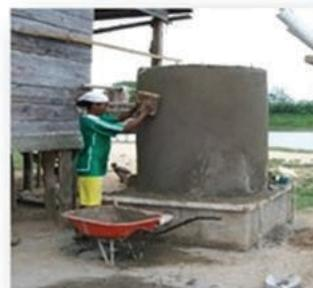
**Cisternas o tanques de ferro cemento**
