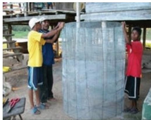
La mezcla arena cemento o bien mortero será con una proporción de 1:4 es decir 1 parte de cemento y 4 partes de arena, para el caso a una bolsa de cemento se debe agregar 6 partes de arena para que se cumpla la proporción 1:4
