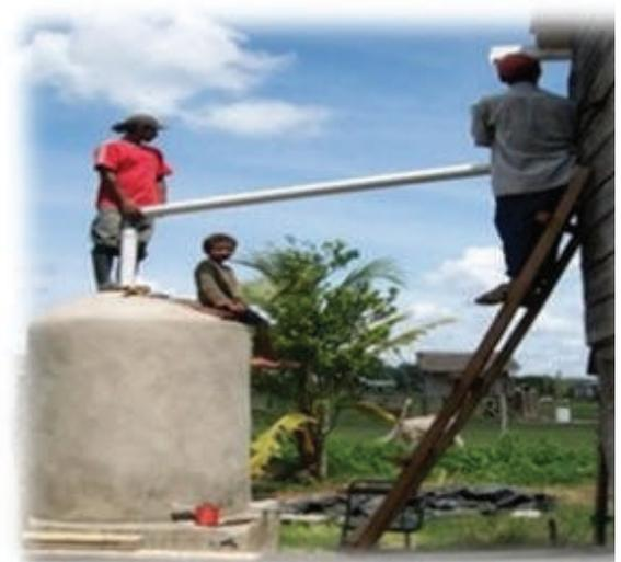
Ya construido el tanque de ferro cemento se procede a construir la tapa de concreto que igualmente llevará una estructura de acero y malla de 4mm. Para ello se aplicará una capa de mezcla en la parte interna y se dejará secar por 24 horas a más tiempo para poder moverla y ubicarla en la parte superior del tanque, que será donde se aplicará la capa externa y acabado final de la misma.
