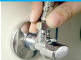
La **“llave de toma”** se encuentra colocada sobre la tubería de la red de distribución y abre el paso a la acometida. Su instalación es conveniente, porque permite hacer tomas en la red y maniobras en las acometidas, sin que la tubería deje de estar en servicio.
